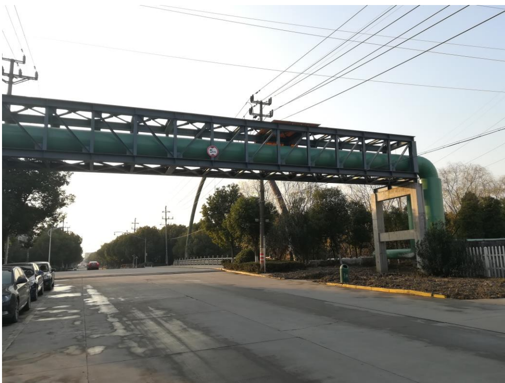
图 6 管网上跨公路走向
